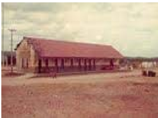
Estação de trem da antiga e submersa São Rafael/RN
